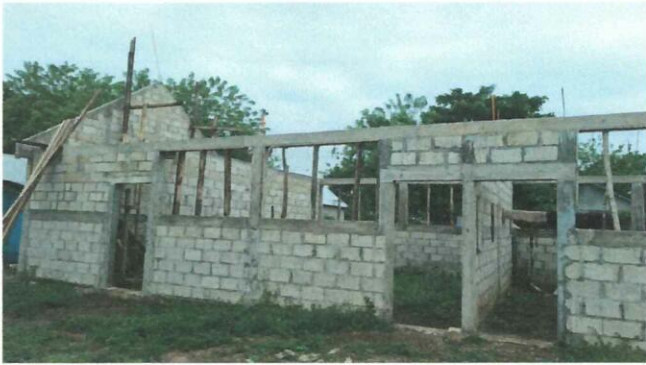
Foto 1: MONTAJE DE ESTRUCTURA DE TECHO
