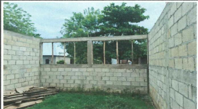
Foto 4: COLOCACION DE TIJERAS EN ESTRUCTURA DE TECHO
